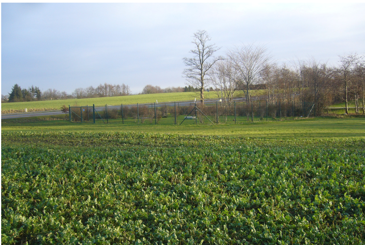
25 meter zone med græs omkring boring til alment vandforsyningsanlæg.
